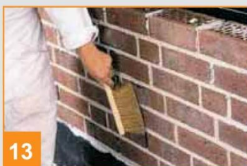
10 Test kciuka daje nam informację kiedy można przystąpić do kształtowania spoiny
