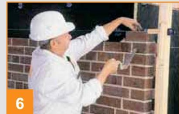
3 Murowanie z jednoczesnym spoinowaniem zapewnia uzyskanie muru wolnego od pustek i ubytków.
