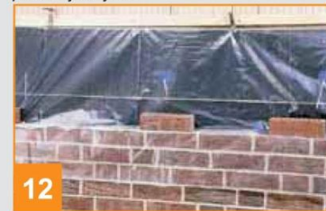
9 Rzut oka na pustkę powietrzną. Zaprawa wychodzi spod cegieł ale się nie odrywa. Dzięki temu przestrzeń między ścianami pozostaje czysta.
