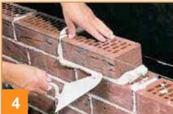
1 Nałożenie zaprawy na spoinę pionową
